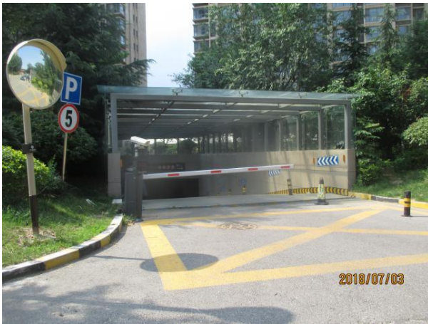
地下停车场入口
